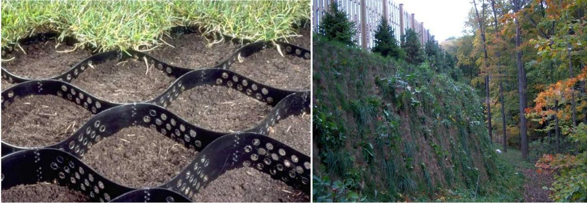
*Système de retenue de terre avec cellules géosynthétiques et résultat d'un talus après plantation.*
